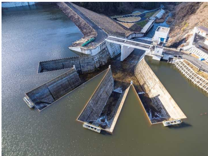
【after】整備状況(令和6年1月) ～試験湛水の洪水時最高水位～
