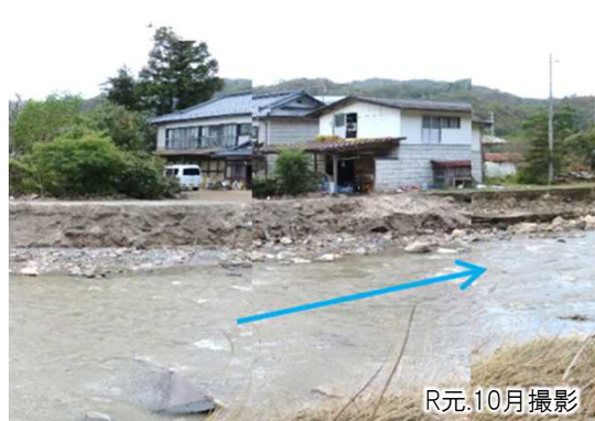
被災状況：広瀬川（川俣町）
