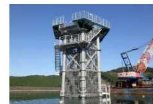
取水設備の整備
