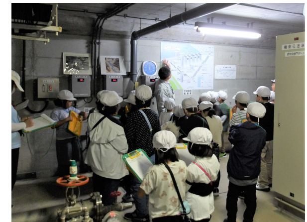
【ダム堤体内での見学説明】
