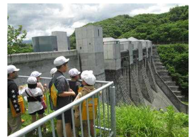
【右岸側からダム堤体の高さを体験】
