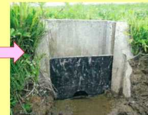
水戸板設置状況
