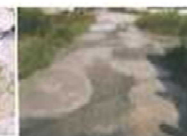
農道の空みの補修
