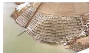
貯水池法面の保護
