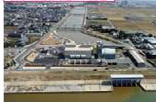
排水機場と周辺の市街地
