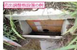
流出調整板設置の例
