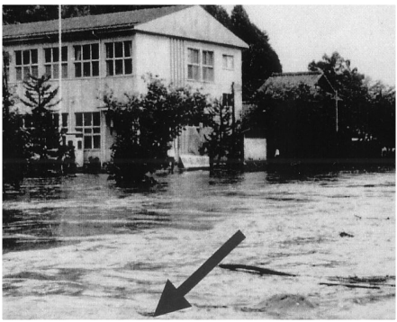
昭和41年9月洪水による浸水状況
