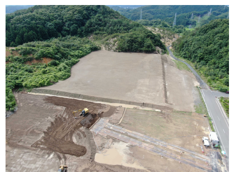
掘削土搬入後 (令和4年7月)
