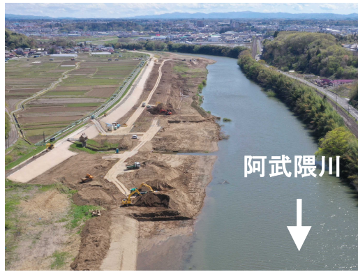
河道掘削の施工状況
