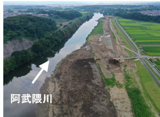
河道掘削の施工状況
