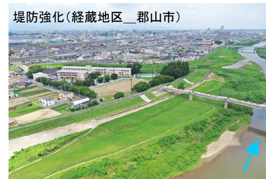
河道掘削(横塚地区_郡山市)
