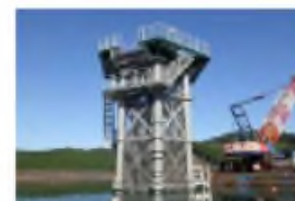
取水設備の整備
