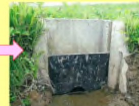
水戸板設置状況
