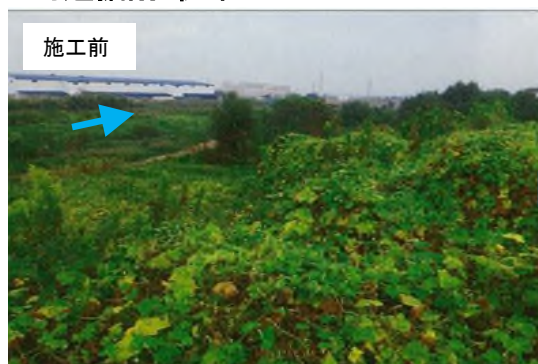
・河道掘削・伐木
