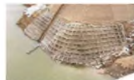
貯水池法面の保護
