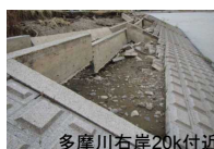
多摩川右岸20k付近
