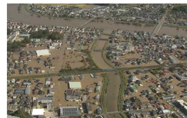
⑩阿武隈川における浸水被害状況 (福島県本宮市)
