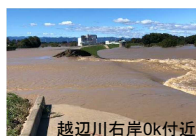
越辺川右岸0k付近
