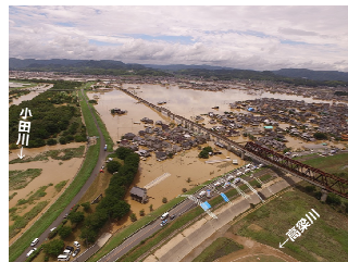
⑤小田川における浸水被害 (岡山県倉敷市)
