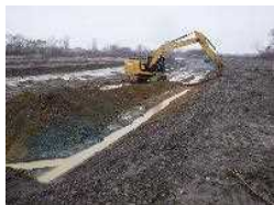
河道掘削 (石狩川水系、北海道開発局)
