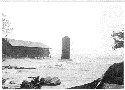
災害当時の状況を収めた貴重な写真。 小川原湖周辺一帯に被害が及び、住宅などの建物は床上浸水した。
