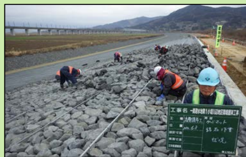
下請会社施工状況
