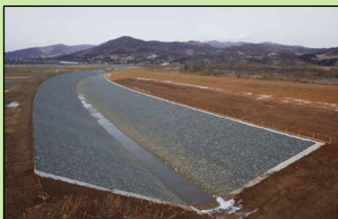
工事完成 (かごマット)
