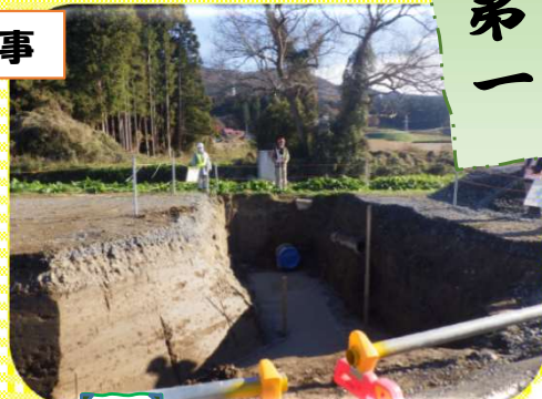
床掘状況の点検
