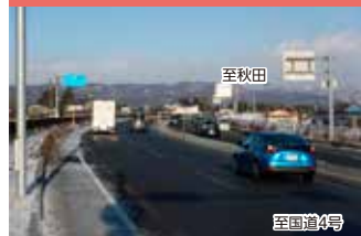
開通済み区間の状況
