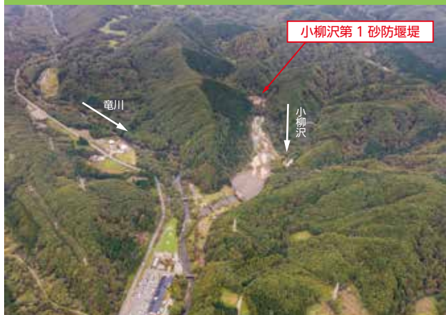
②小柳第1砂防堰堤 R7実施内容：砂防堰堤工
