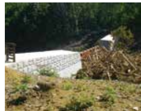
土石流発生後（H25年9月17日）
