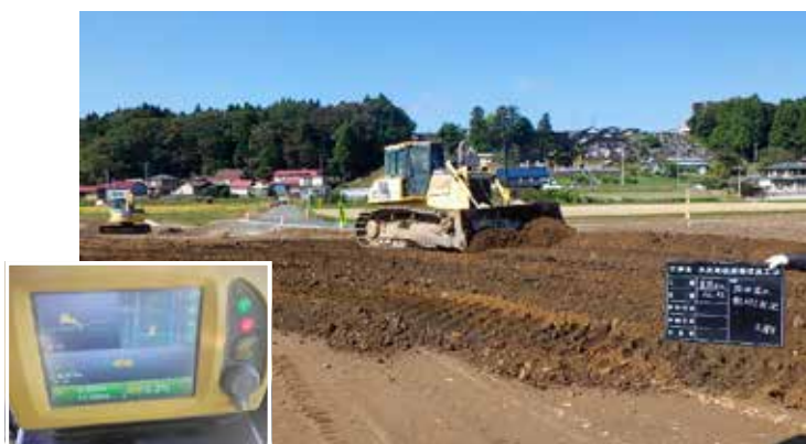
ICT建設機械による盛土施工
