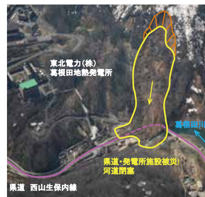
葛根田川で発生した大規模崩壊
