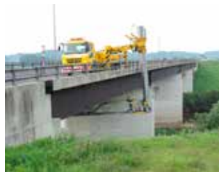
橋梁定期点検
