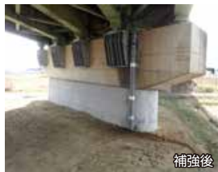
橋梁耐震補強 (横変位拘束構造)
