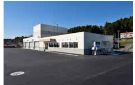
防災除雪ステーション(R5.11完成)
