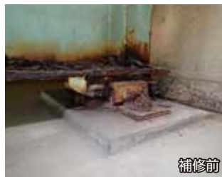
橋梁補修(主桁補修工、支承取替工)
