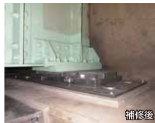
橋梁補修(主桁補修工、支承取替工)
