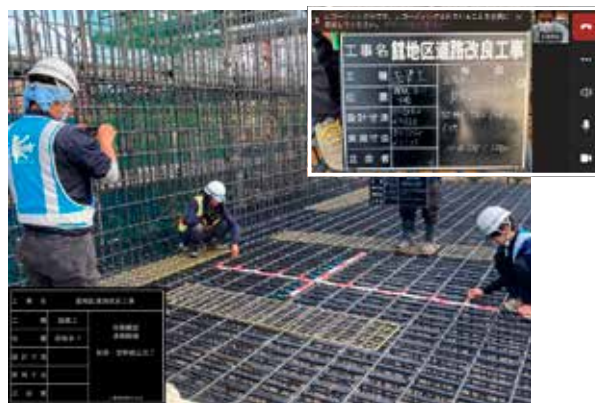
遠隔臨場による鉄筋出来形測定
