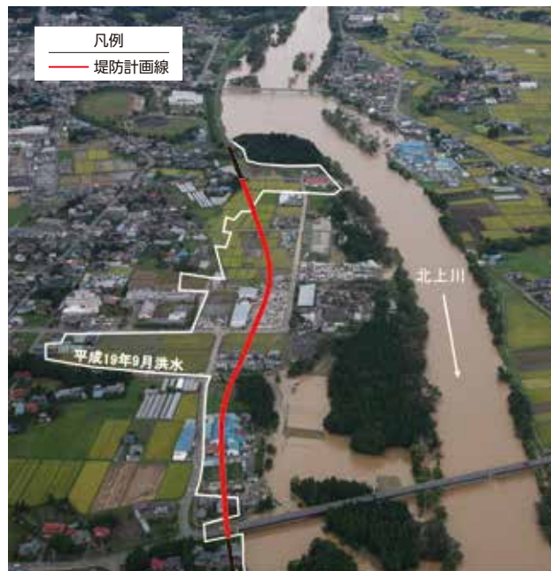
(岩手県紫波郡紫波町) 平成19年9月洪水
