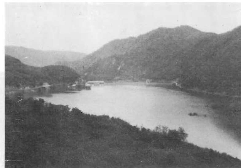
下嵐江砂防地域より石淵ダムを望む
