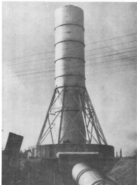
胆沢第2発電所サーチャージタンク
