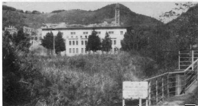
中津川水系米内川米内発電所
