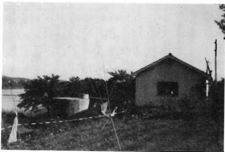
日 詰 上 水 道 取 水 所
