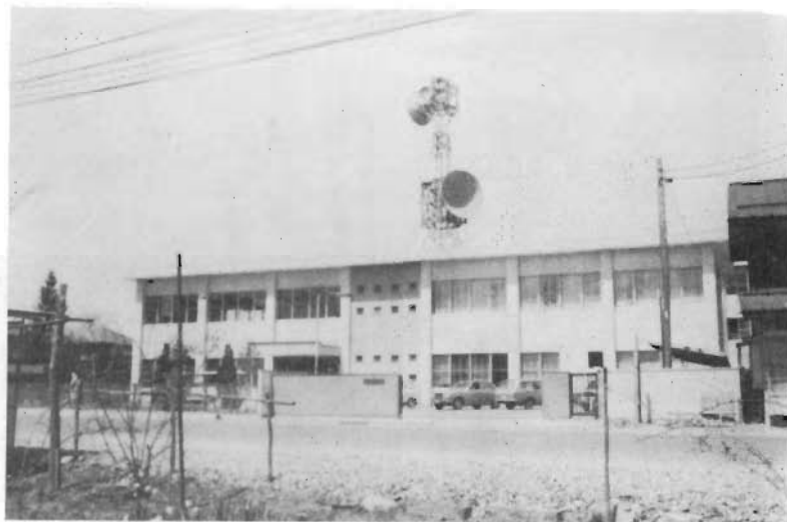
岩手工事事務所 (S.41.)
