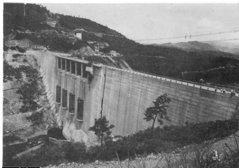
田瀬ダム上流面（左支猿ヶ石川 和賀郡東和町）
