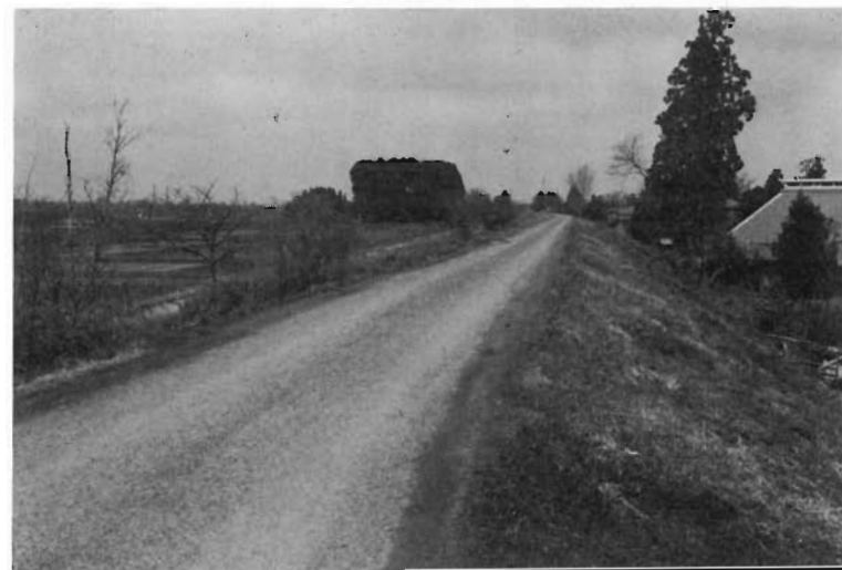
31 岩谷堂堤防（愛宕下流）下流部（中央の森は川島神社）
