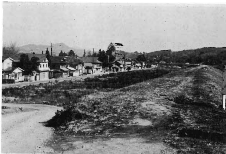
1 日形堤防（改良工事）（昭45） 花泉町日形字町下より上流を見る
