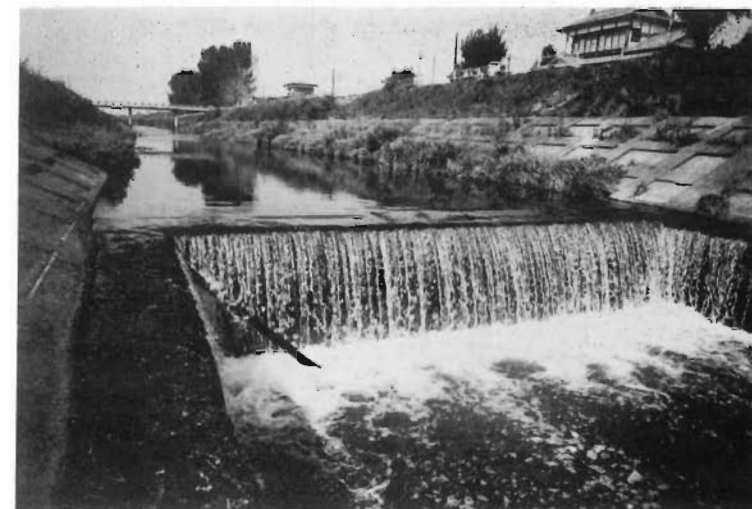
105 黒沢川付替 合流点落差工
