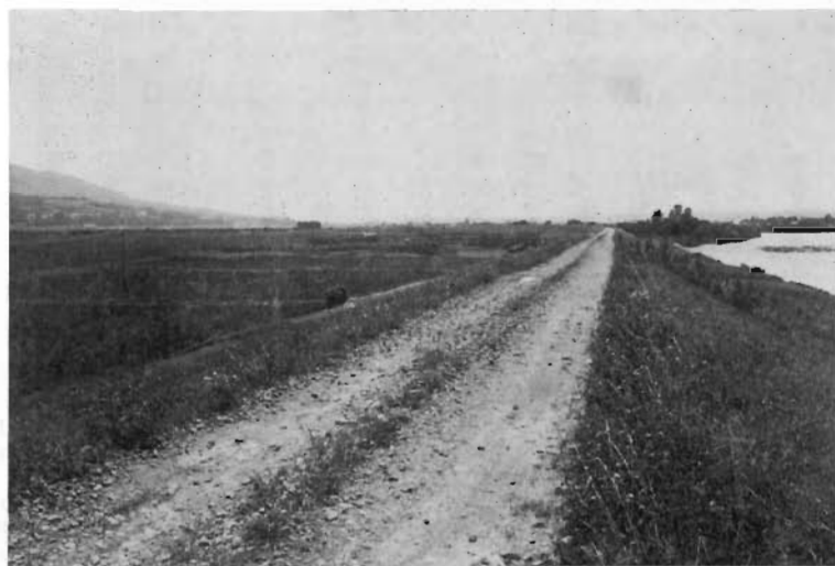
12 生母黒石堤防（二渡地先より下流方面を見る） 写真8と同一地点に於ける完成堤
