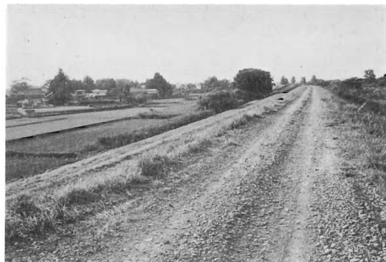
22 姉体上流堤防 草井沼地先
