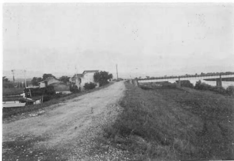
26 羽田堤防（昭52）中袋地先 （計画写真25と同一附近）
