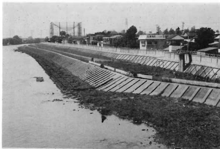
87 盛岡左岸堤防を望む 明治橋より
