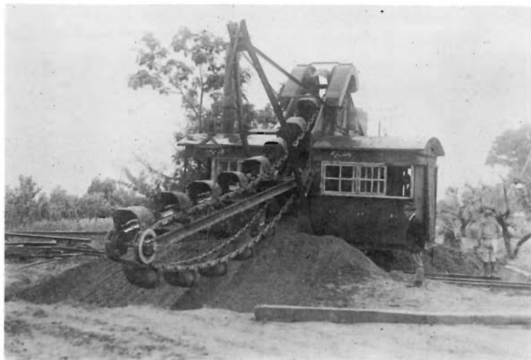
ラダーエクスキャベーター（スチームエンジン60馬力） 昭和25年白山堤防
