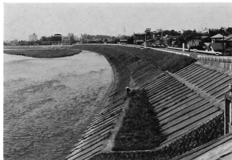
84 盛岡左岸堤防 南大橋より
