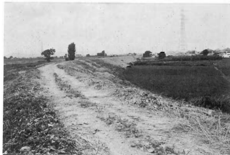
81 築川堤防 直立地先
