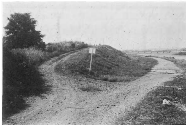
90 盛岡右岸堤防起点 南仙北三丁目旧称小淵
