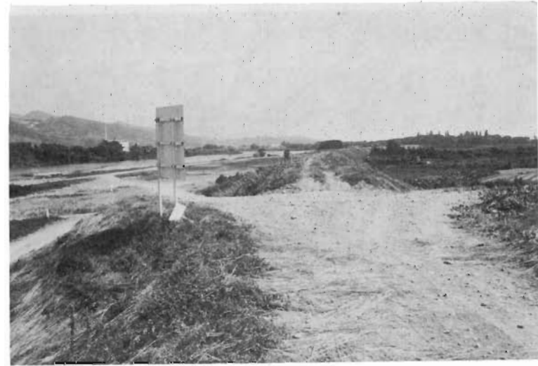
89 津志田堤防 左方北上川 字西門より下流を見る
