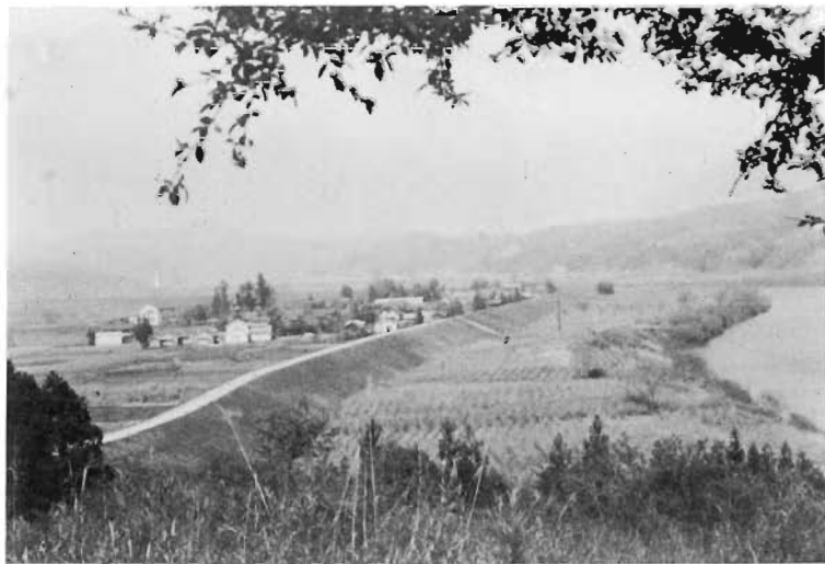
改良工事が施工される日形堤防
