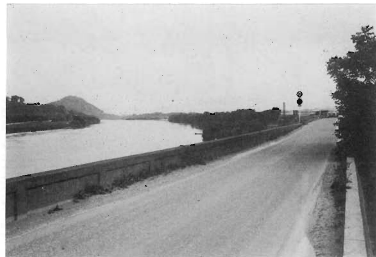
54 黒沢尻特殊堤及び堤防 下川岸地先
