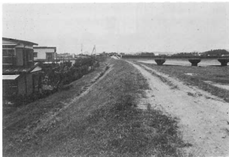
92 盛岡右岸堤 南大橋より下流部
