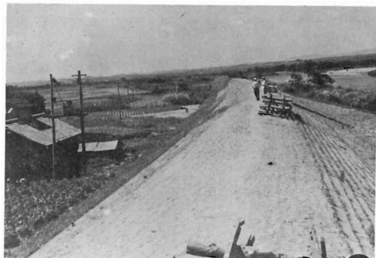
10 生母黒石堤防緊急断面完成（昭25）
