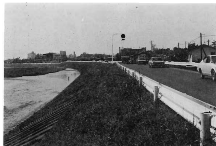
85 盛岡左岸堤防 神子田町地先
