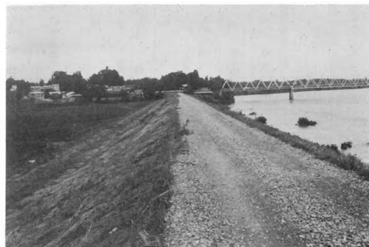
46 金ヶ崎堤防 字龍馬下地先
