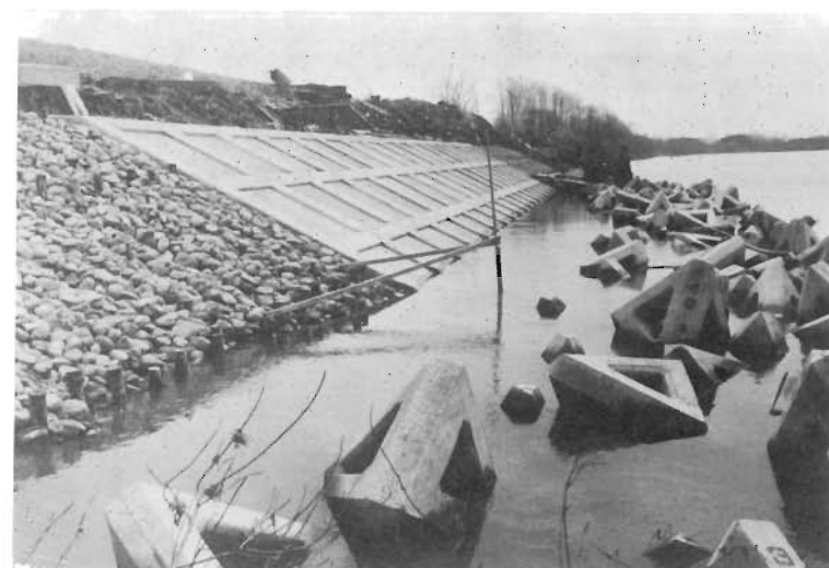
根 固 工 (三角中空ブロック)
