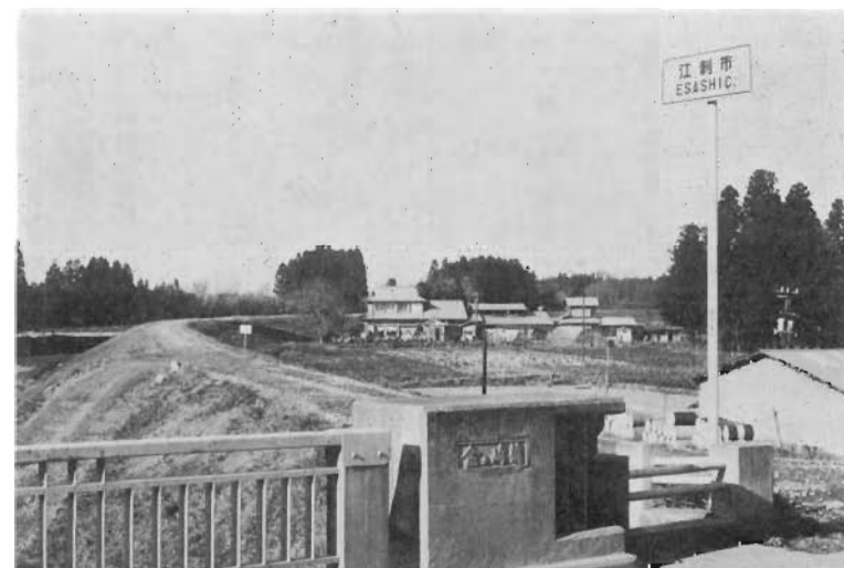
43 愛宕堤防（稲瀬下流）既定断面完成 稲瀬字小荒瀬地内
