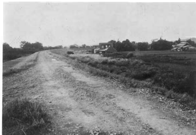
28 羽田堤防（人首川筋）完成堤 水沢市羽田森 工事写真と同一地点
