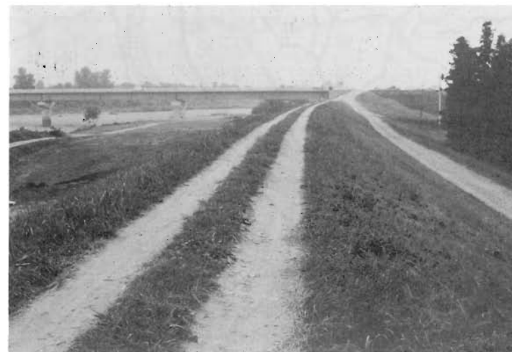
19 姉体下流堤防(昭52)
