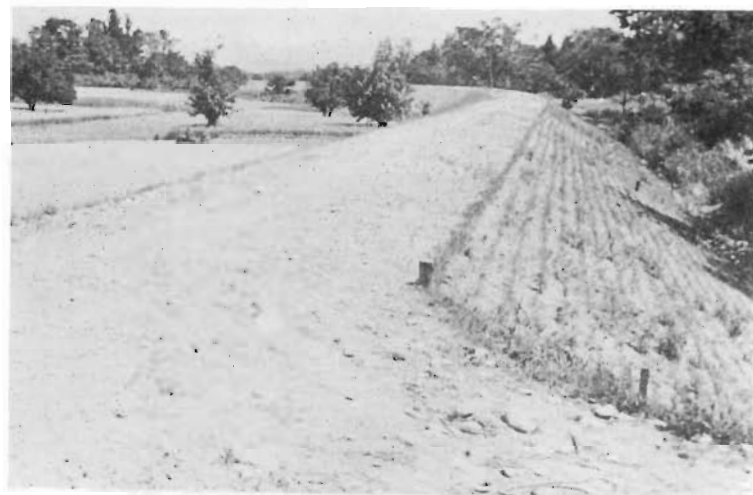
38 愛宕上流堤防(愛宕上流)緊急断面完成(昭26) 愛宕村字三日町地先(終点より下流を見る)
