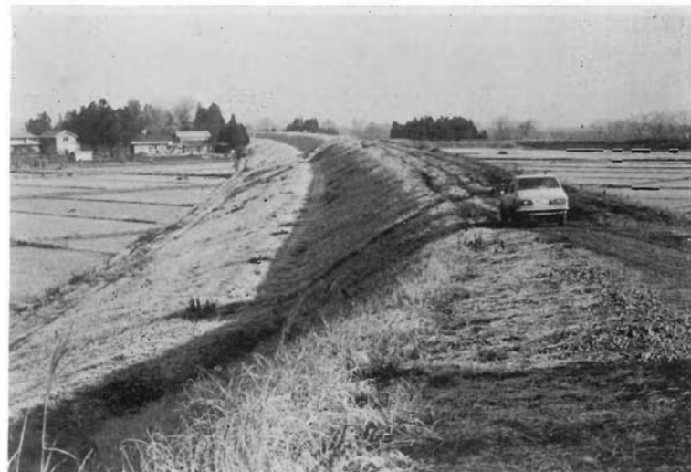
14 前沢堤防 (附56) 前沢町白鳥 赤生津橋附近より上流を見る
