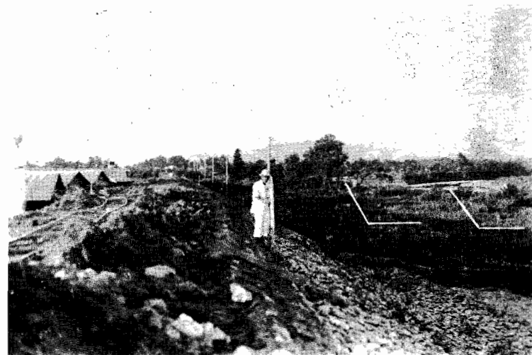
60 花巻堤防(昭24) 花巻町高木字小舟渡より上流を見る(災害復旧工事)
