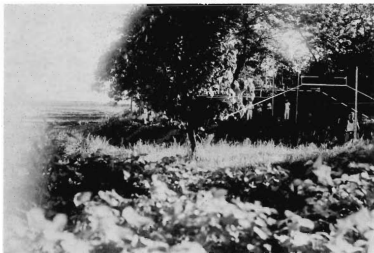
50 黒沢尻堤防計画(昭24) (黒沢尻町黒沢川合流点より)
