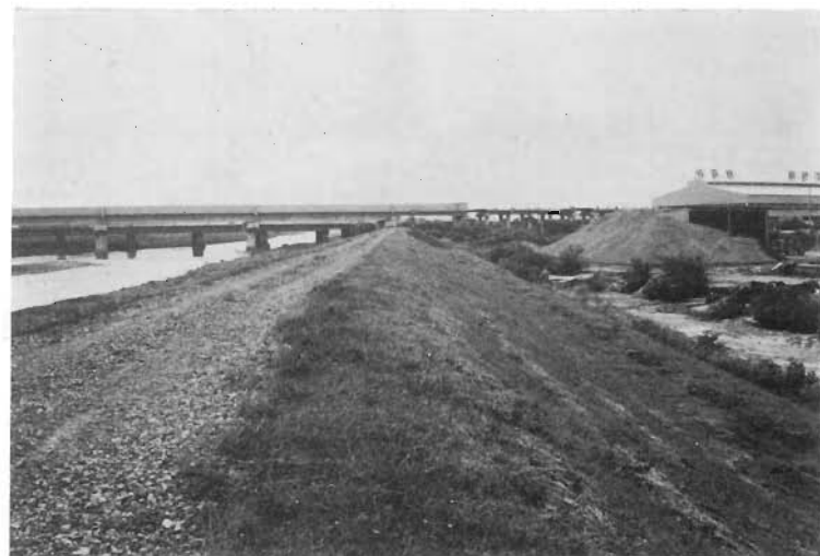
55 和賀川左岸堤 (川原町地先)
