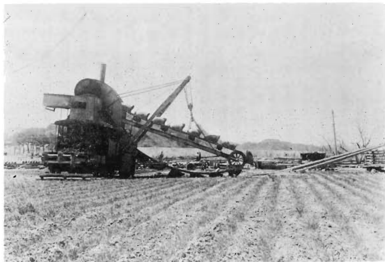
ラダーエクスキャベーター（スチームエンジン） 昭和24年一関ショートカット
