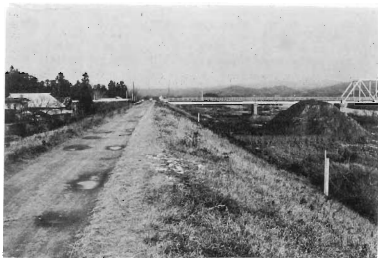
16 白山堤防 大曲橋下流より
