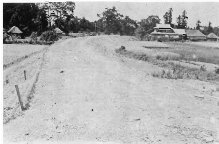
42 愛宕堤防（稲瀬下流）緊急断面完成（昭25） 稲瀬村字小荒瀬地内（起点附近）
