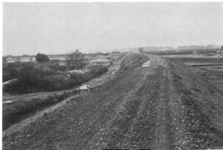
47 胆 沢 川 堤 防 下流より国道4号再巡橋方面を見る
