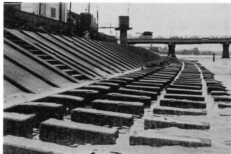
94 盛岡右岸堤防及護岸
