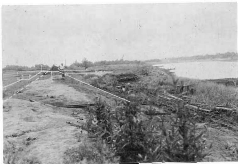
36 愛宕堤防（愛宕上流）計画（昭24） 愛宕村字梶角 （距離標53K附近より下流を見る）
