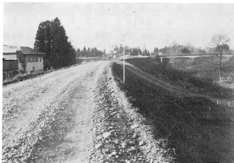
23 姉体上流堤防(昭50) 小谷木橋附近 水沢市羽田字草井沼より上流を見る
