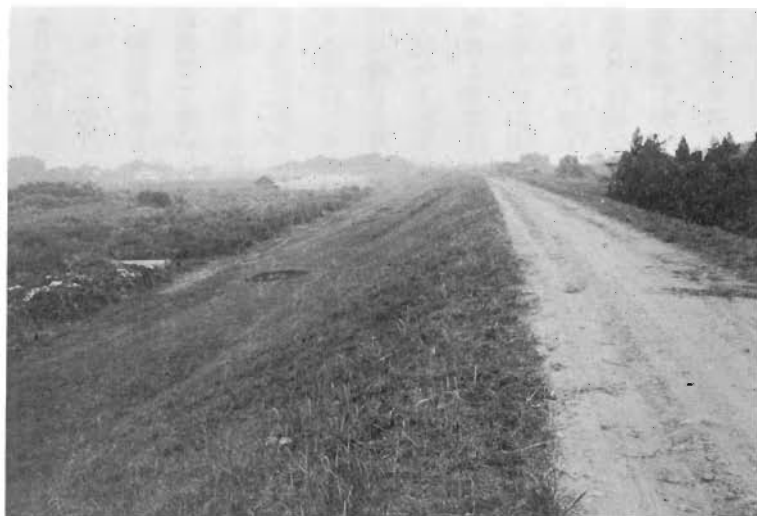
20 姉体下流堤防(昭52)字新田(水沢市姉体)
