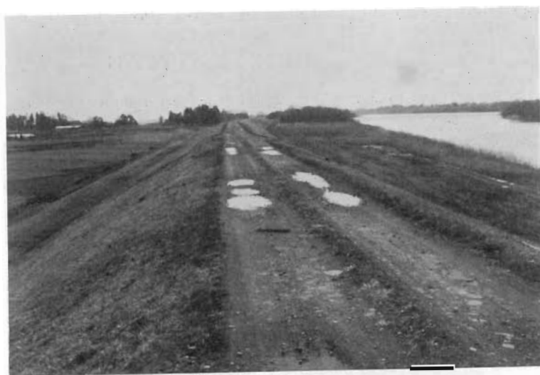
37 愛宕堤防(愛宕上流) 愛宕尾角 (写真36と同一地点距離標63K附近より下流を見る)
