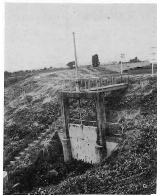
82 築川樋管 直立地先
