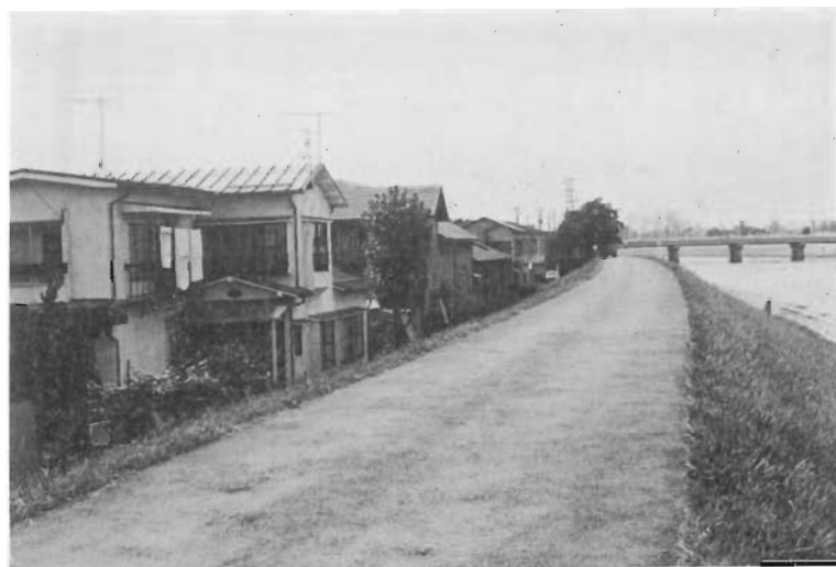
93 盛岡右岸堤 東仙北三丁目地先
