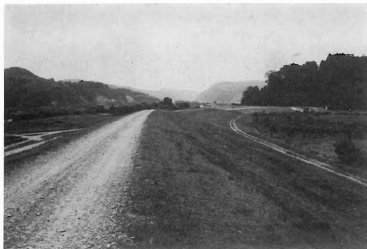
5 弥 栄 堤 防 (工事中)
