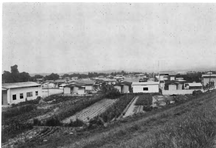
34 江刺市愛宕桜木団地（岩谷堂堤防地区）
