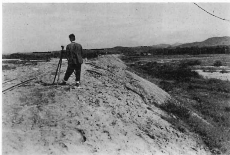
9 生母黒石堤防工事（昭25）
