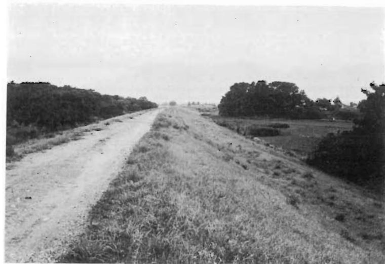
39 愛宕堤防完成堤 起点附近
