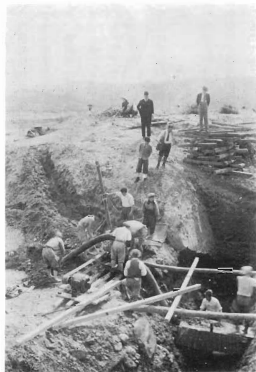
97 中里堤防 吸川樋管基礎掘削 (昭24.3)
