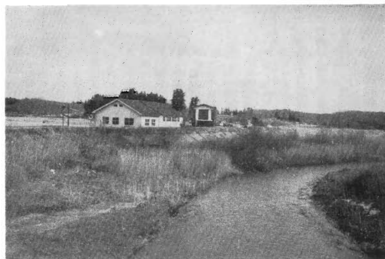
27 夏 川 堤 防 (石崎ポンプ場附近)
