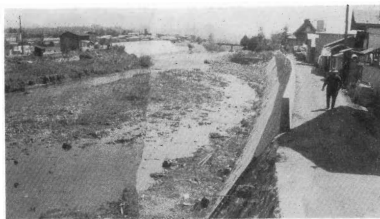
30-2 人首川改良工事 (岩手県施工)
