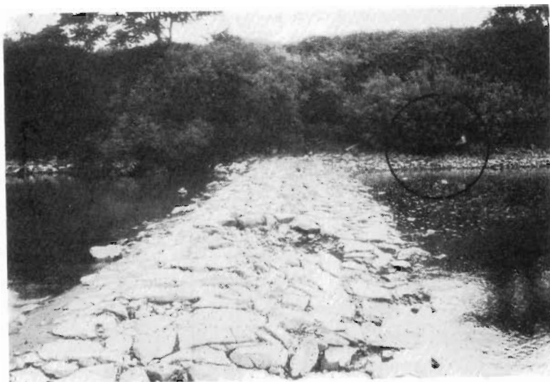
34 第528号 水 制 基 部 (水制本体上より基部を見る)
