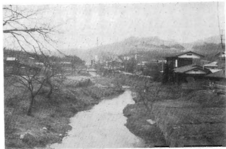
29 千 厩 川 堤 防 (S45.11.8)
