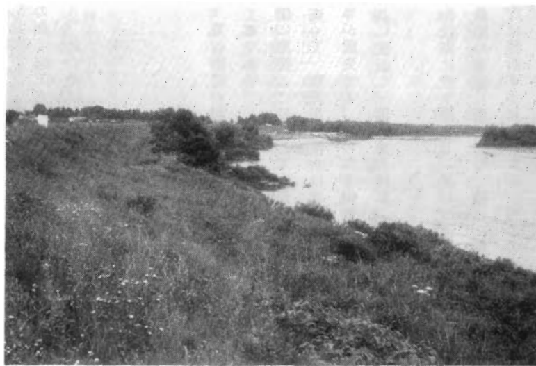
2-2 荒谷前における水制群 (S48.6.12) (昭和前期の工事)
