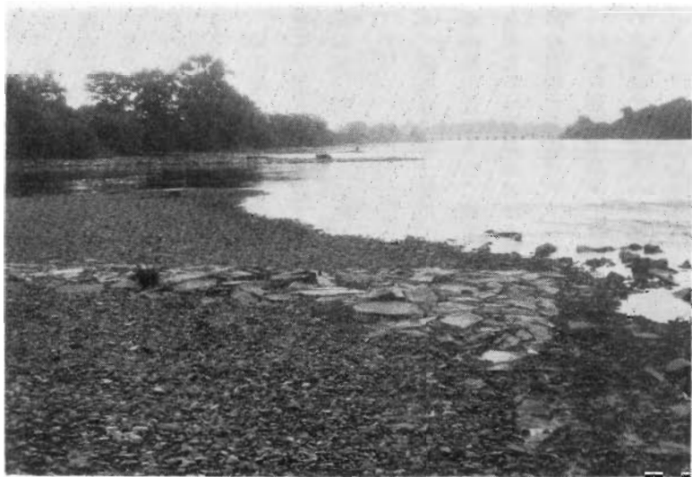
18 第528号水制より上流を見る（遠景に千才橋が見える）
