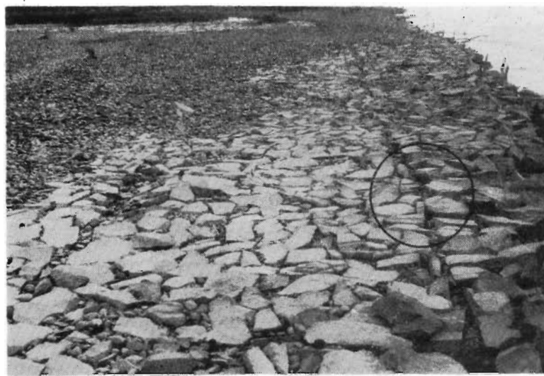
36 第528号 水制頭部構造 頭部（右上部本流）両側に笹の線が見える
