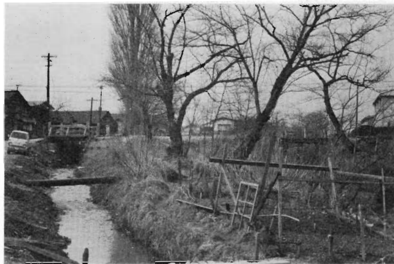
旧上北川河道に架する一日市橋
