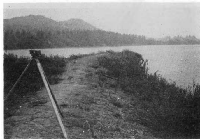
相去 沈床の現況 (S44.10)
