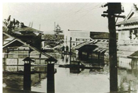
昭和22年9月（カスリン台風）による
