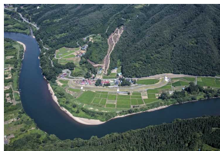
北上川狹隘地区治水対策事業の輪中堤整備状況 (一関市小日形地区)
