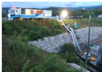
排水ポンプ車稼働状況(宮古市)
