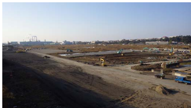
写真6 日和大橋より公園区域を望む
