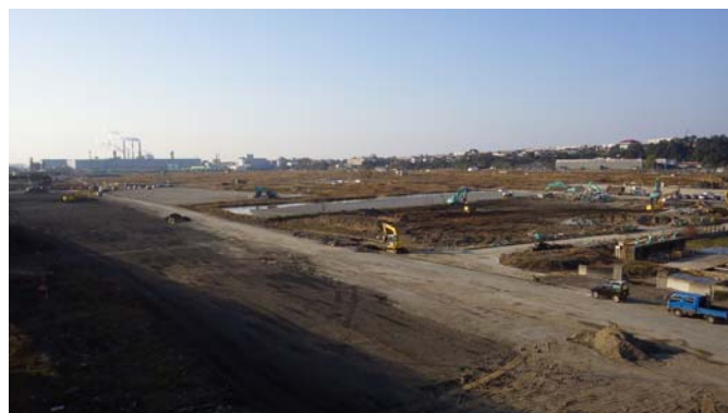
写真6 日和大橋より公園区域を望む
