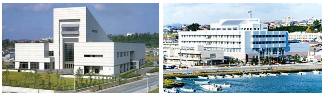
写真6 石巻文化センター（左）と石巻市立病院（右）
