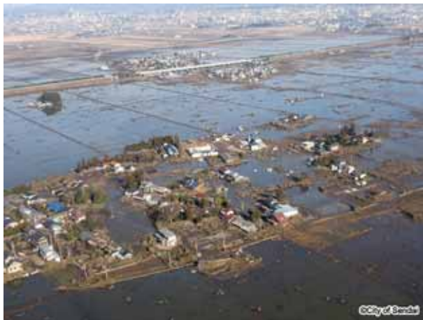
写真 1-1 平野部の被害（仙台市）
