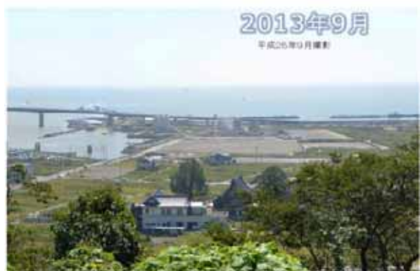
写真4 南浜地区のがれきが撤去され更地となっていく過程
