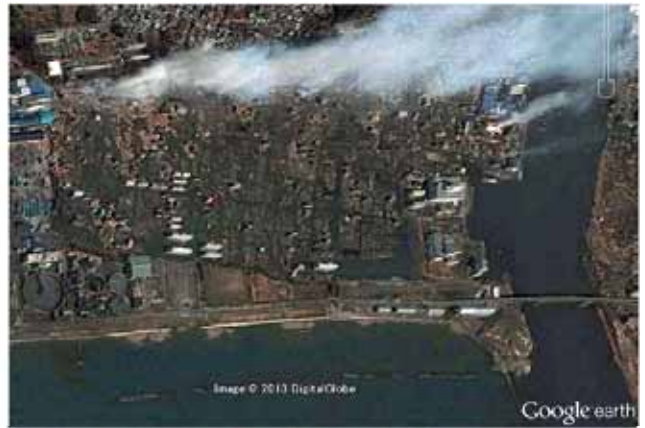
震災後の南浜地区 2011年3月12日撮影
