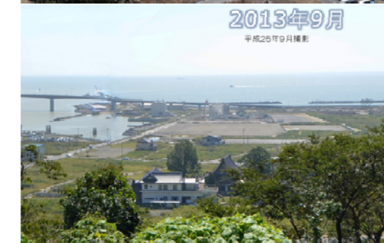
写真 南浜地区のがれきが撤去され更地となっていく過程 (写真提供) 石巻市(上) 石巻百景(他)
