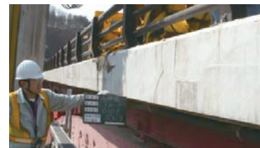
地覆補修時の状況
