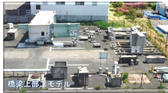
コンクリート構造物
