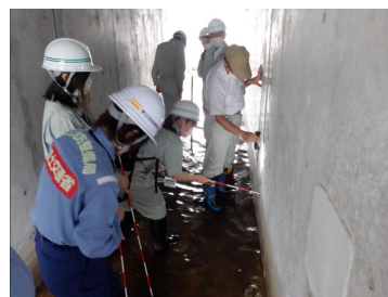
写真：函体内部の変状確認の実習
