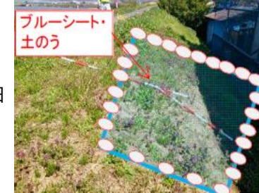
写真：「はらみ出し」の应急対策例
