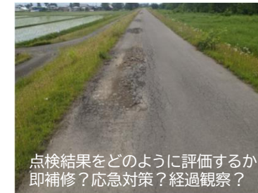
写真：堤防天端の載荷重による沈下
