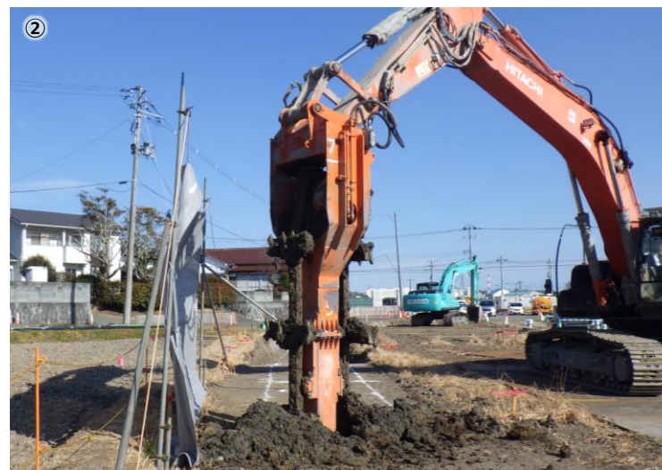
機械による地盤改良工事の施工状況
