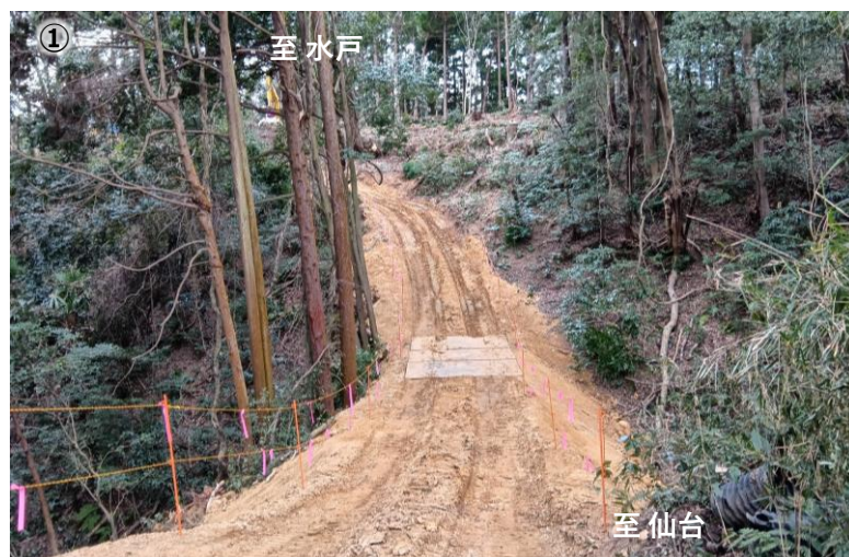
樹木伐採に伴う進入路の施工状況
