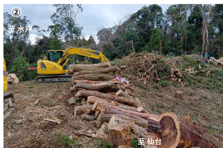
土工工事伴う樹木伐採の施工状況
