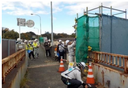
現場点検の様子
