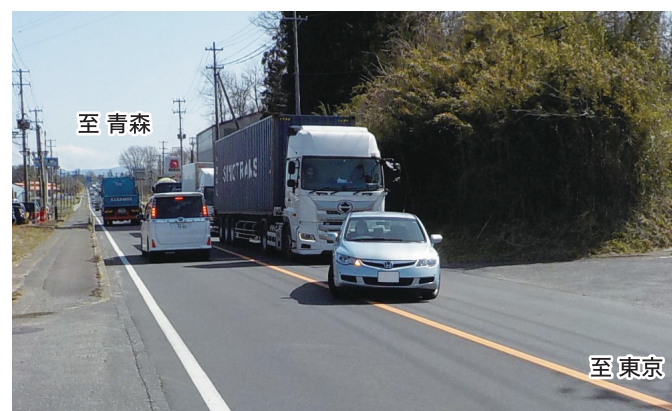
右折レーン未整備箇所(北浦交差点)
