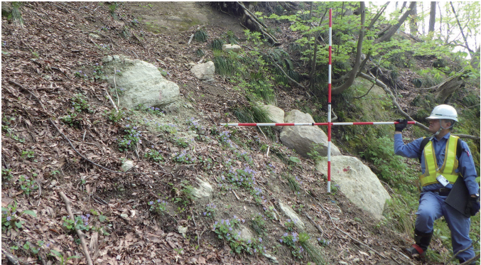
法面（転石・浮き石）の点検
