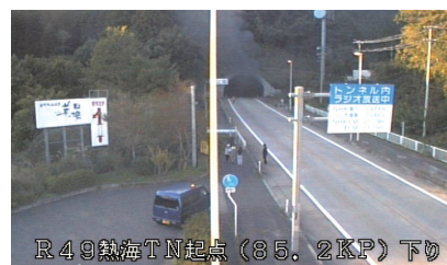
R49熱海TN起点(85.2KP)下の トンネル火災の発見 (国道49号熱海トンネル)
