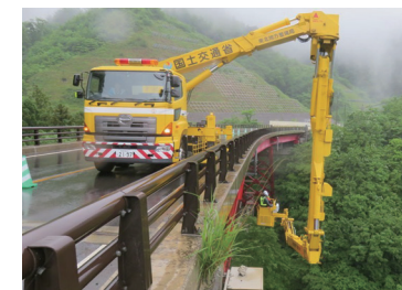
橋梁点検車による点検
