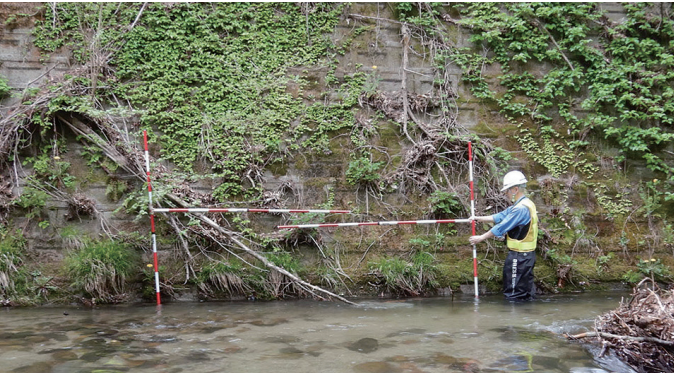
擁壁（護岸）の点検
