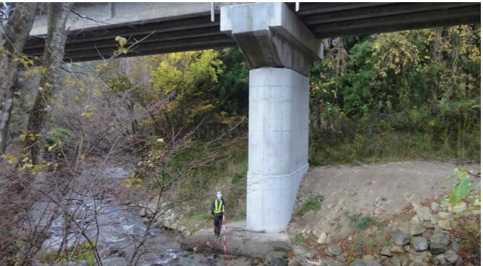
橋脚基礎洗掘の点検
