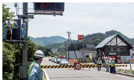
国道49号事前通行規制区間における遮断機訓練 (西会津遮断機)
