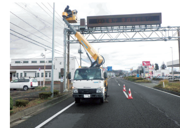
道路付属物(道路情報板)近接目視
