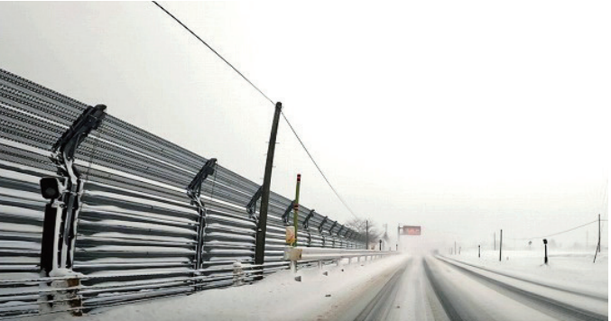
対策（防雪柵設置）後の点検
