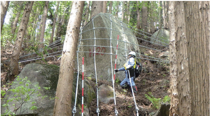
対策（ロープ掛け）後の点検
