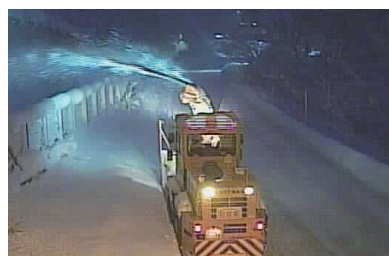
拡幅除雪の状況
