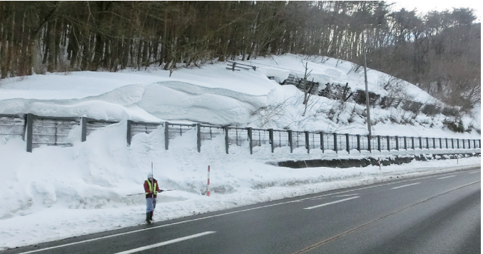
雪庇発生状況の点検
