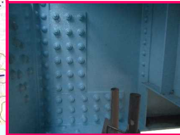
① 補修完了
