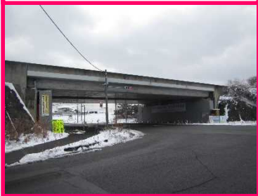
② 原跨道橋
