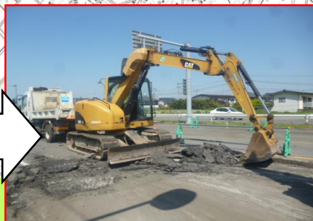
工事に着手しました (舗装版取り壊し)
