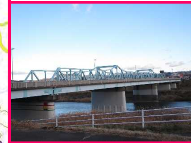
① 金山橋塗装完了
