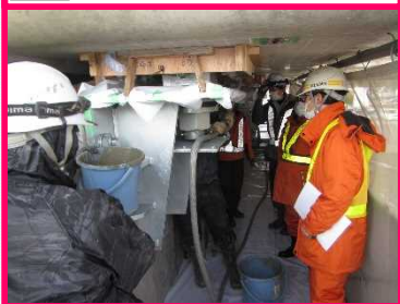
② モルタル充填中
