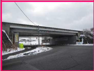
② 原跨道橋
