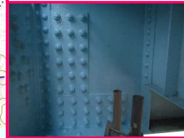
① 補修完了
