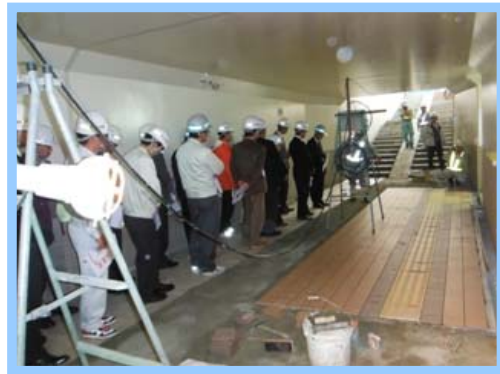
地下通路部分にタイルを敷き詰めている途中です。
