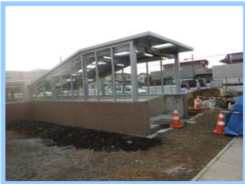
地下道に出入りする階段の上屋です。
