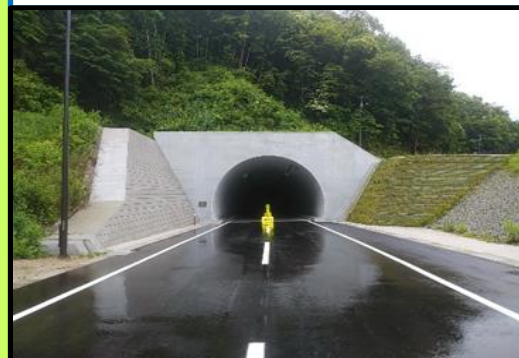
1 矢大臣山トンネル完成状況
