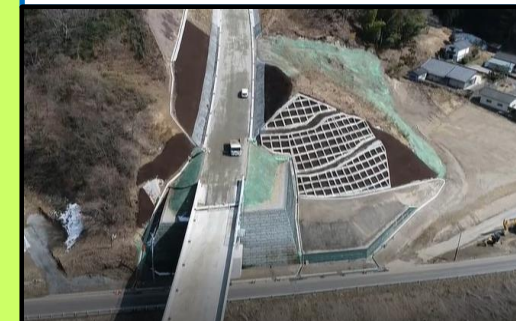
5 貝谷大橋A1橋台側補強土壁施工状況
