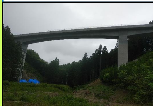
3 矢大臣大橋完成状況
