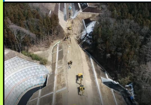
4 市道下町不動入線施工状況
