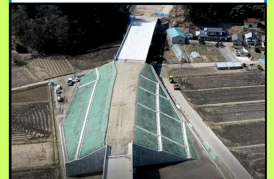
6 貝谷2号大橋施工状況
