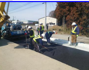
③ 上層路盤敷均し状況
