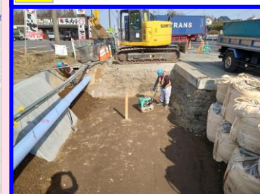
⑤ 路床盛土施工状況
