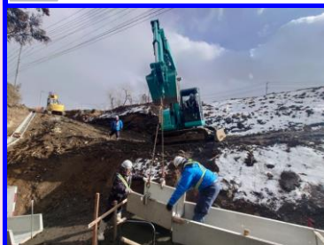
③ 排水構造物敷設状況
