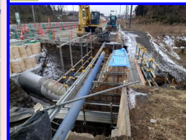
⑤ 重力式擁壁型枠組完了
