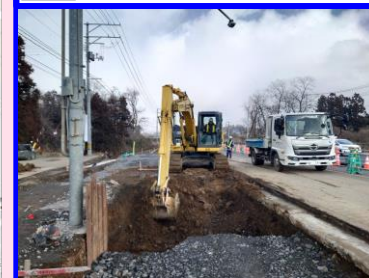
④ 置換掘削状況
