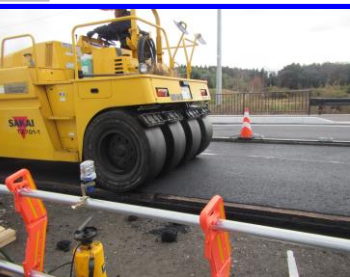
③ 舗装締め固め
