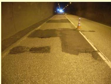
▲大滝第二トンネルの舗装劣化状況
