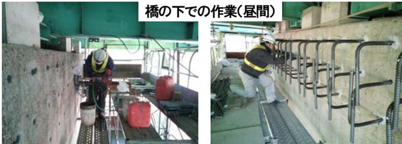
橋を支える土台を拡げるため、今ある土台(コンクリート)に穴を開けて鉄筋を差し込んでいます。この後、コンクリートを流して土台を拡げます。
