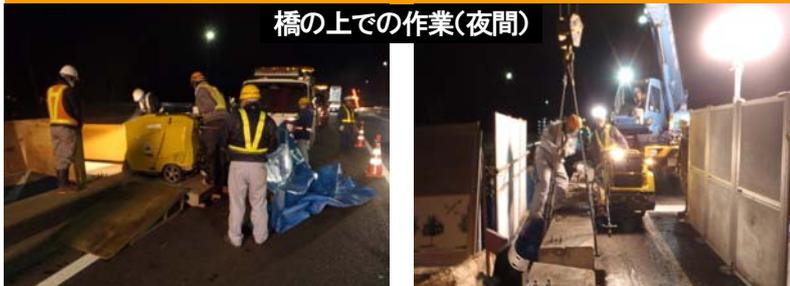
橋の幅を拡げるのに支障となるコンクリートの切断・取り壊しをしています。(橋の)土台を拡げた後、橋の幅を拡げて、右折車線を設置します。
