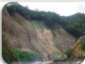
法面にロックボルトを設置する為削孔を行っています R3.6/3現在
