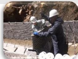
側壁工の底盤を作っています R3.6/1現在
