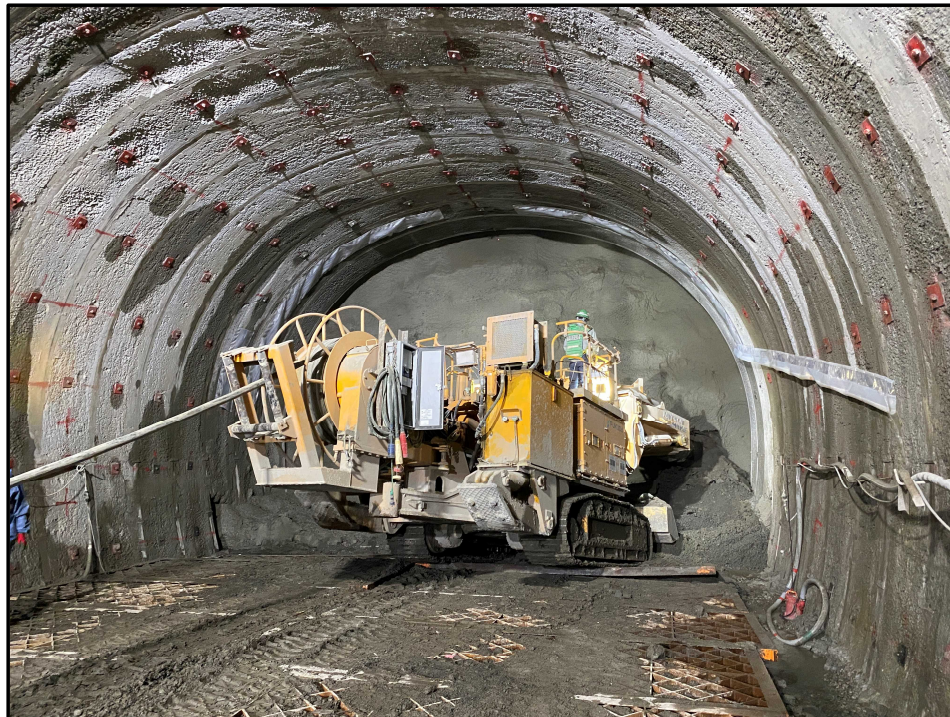
起点側 (トンネル掘削)
