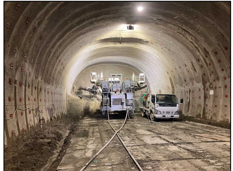
終点側 (トンネル掘削)
