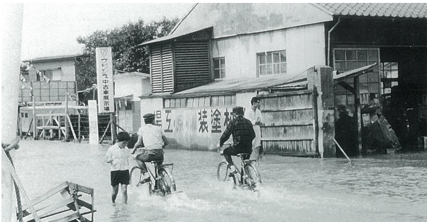
国道 115 号の冠水状況（福島県福島市）
