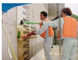
量水板の清掃状況
