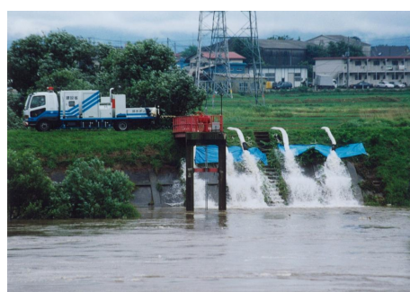
排水ポンプ車稼動状況(郡山市)
