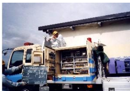
排水ポンプ車点検の様子
