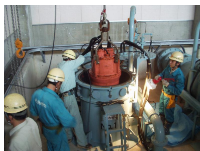
排水機場点検の様子
