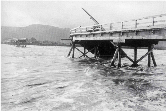
伊達崎橋の流失（福島県伊達市）
