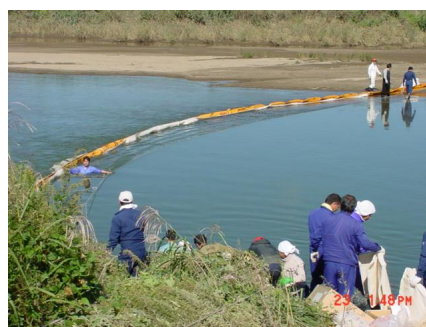
平成 13 年 9 月 23 日 重油の流出事故発生時に設置した オイルフェンス (福島県須賀川市)
