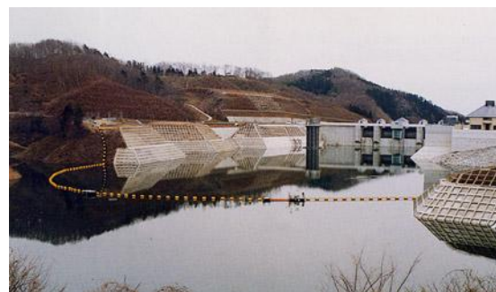
三春ダム 流木止施設
