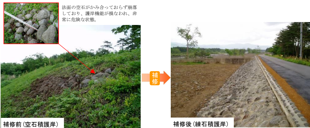
空石積護岸の補修(支川荒川)
