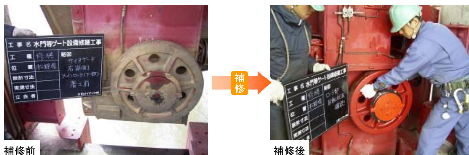
ゲート設備の維持補修
