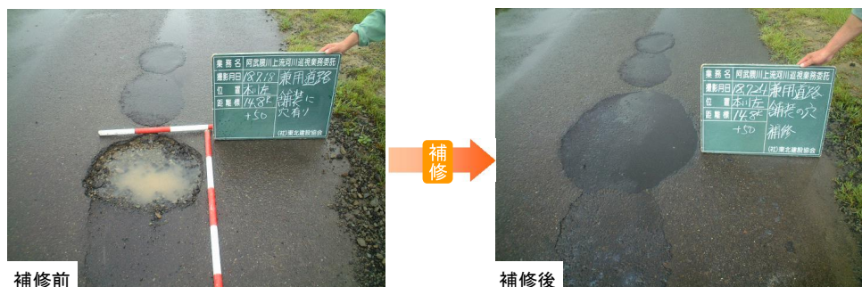
堤防天端舗装の補修
