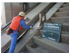
係船レールの点検状況
