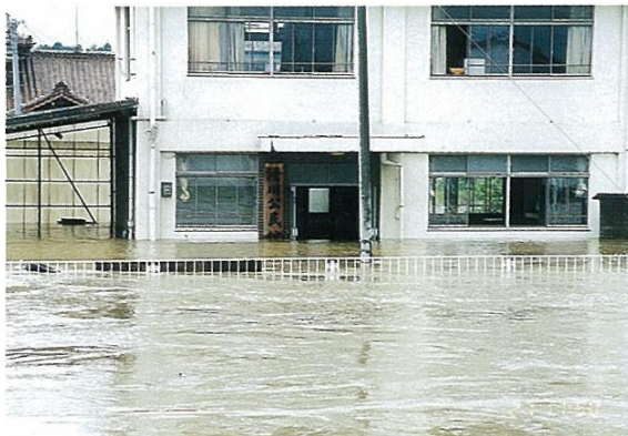
滑川公民館の浸水 (福島県須賀川市)
