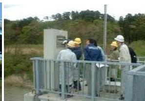
施設点検の様子
