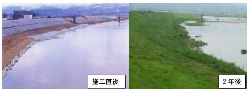
平成の大改修で行われた多自然川づくりの例(河口より 60km 付近)
