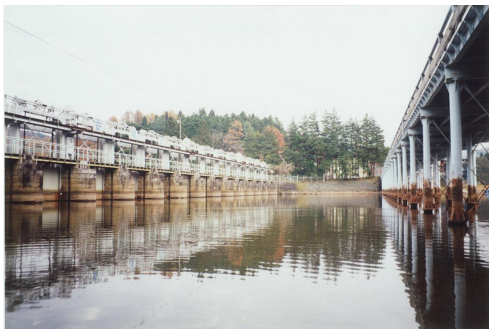
安積疏水の取水口(十六橋水門)
