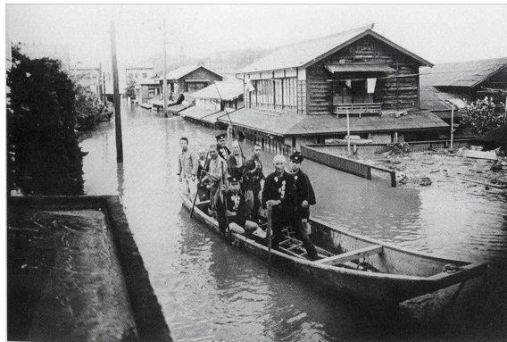
本宮町役場の冠水状況
