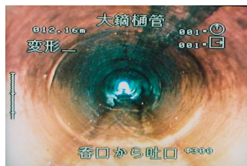
日常点検が困難な 小口径樋管の変形状況
