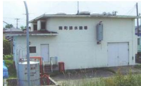
南町排水機場(福島市)
