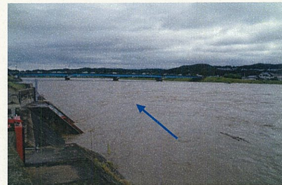
本宮市 昭代橋付近の状況 (68.1kp 付近)
