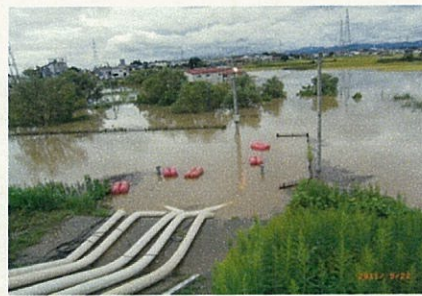
排水ポンプ車による内水排除状況 (郡山市 水穴樋管 81.6kp 左岸付近)
