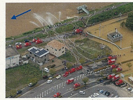
消防による内水排除状況 (郡山市 新堀川樋管 86.8kp 付近)
