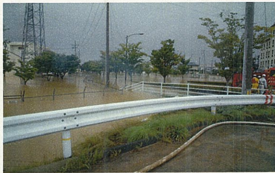
郡山市 行合橋上流付近の浸水状況 (86.8kp 左岸付近)
