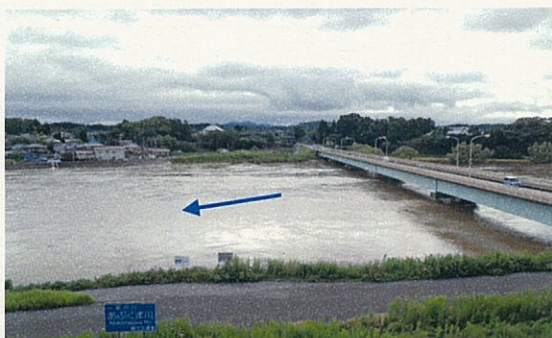
郡山市 阿久津橋付近の状況 (阿武隈川 83.8kp付近)
