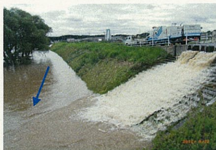
排水ポンプ車による内水排除状況 (郡山市 水穴樋管 81.6kp 左岸付近)
