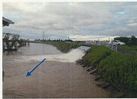
排水機場による内水排除状況 (郡山市 愛宕川排水機場 83.3kp 左岸付近)
