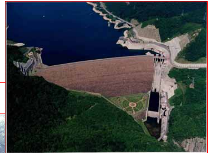
七ヶ宿ダム(平成3年竣工)
