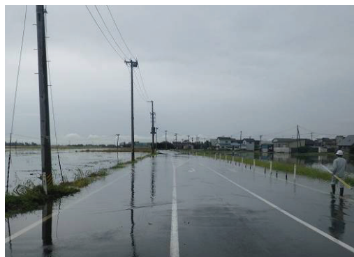
台風 15 号（平成 23 年 9 月）による 一般県道岩沼海浜緑地線の浸水状況
