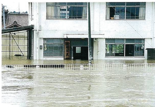
滑川公民館の浸水 (福島県須賀川市)
