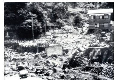
荒川右支川東鴉川の土石流被害
