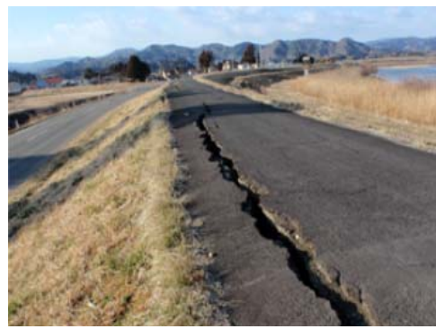
地震による堤防縦断亀裂 (阿武隈川右岸33.0k付近 (丸森町小齊地先))
