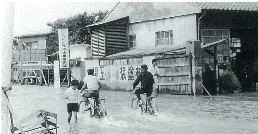
国道 115 号の冠水状況（福島県福島市）
