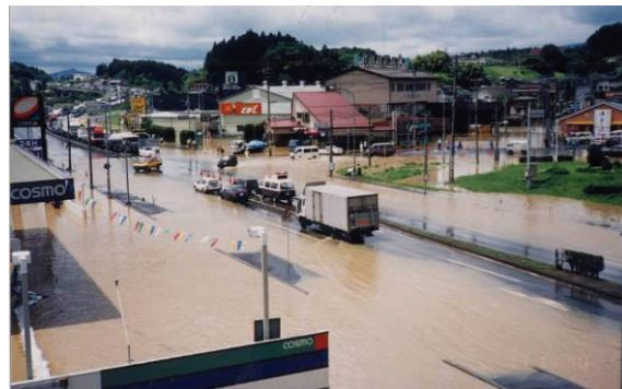
国道 4 号の浸水状況 (福島県二本松市)
