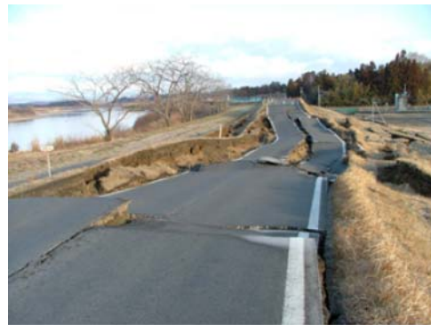
地震による堤防沈下と天端の陥没 (阿武隈川右岸22.0k付近 (角田市坂津田地先))
