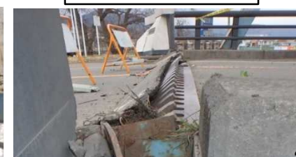
A 2 伸縮装置の破損
