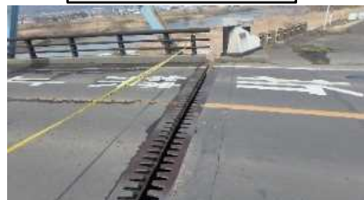
A 1 伸縮装置の破損
