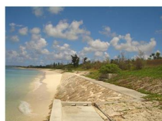
緩傾斜護岸の整備状況
