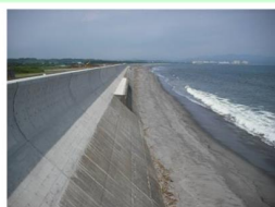
堤防整備状況
