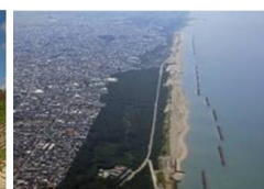
離岸堤の整備状況
