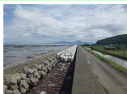
消波ブロック整備状況
