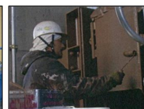
(ゲートの塗装)
