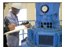
(ポンプの点検整備)
