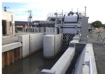
雨水ポンプ場の整備
