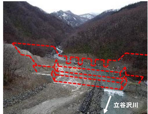
砂防堰堤の整備を推進し、土砂・洪水氾濫による被害の防止・軽減を図ります。
