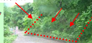
今年6月の土砂崩落(西川町見附林道)
