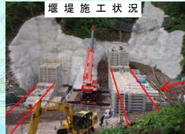
堰堤施工状況
