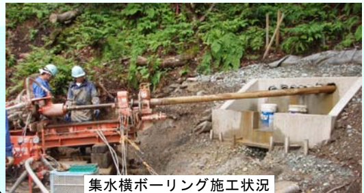
集水横ボーリング施工状況
