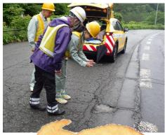
万世町の駐車帯で、路面補修 に挑戦!! まずは、補修前の状態を パトロール用のタブレットで撮影します。 穴ぼこに常温合材を入れ、スコップで ならし、水をかけ踏みならしました。 これで完了!
