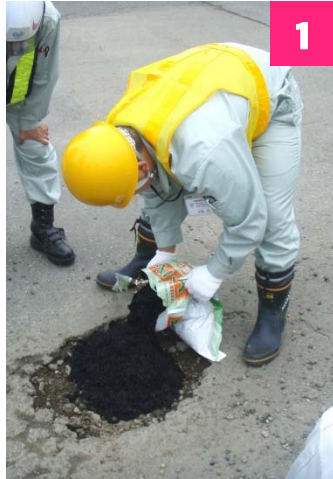
① 凹みに補修材を敷き詰めます。
