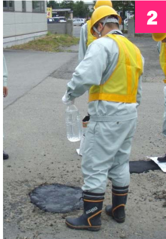
② 敷き詰めた補修材の上に水をかけます。
