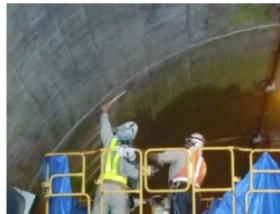
◀実際にトンネル内で打音検査をしている様子
